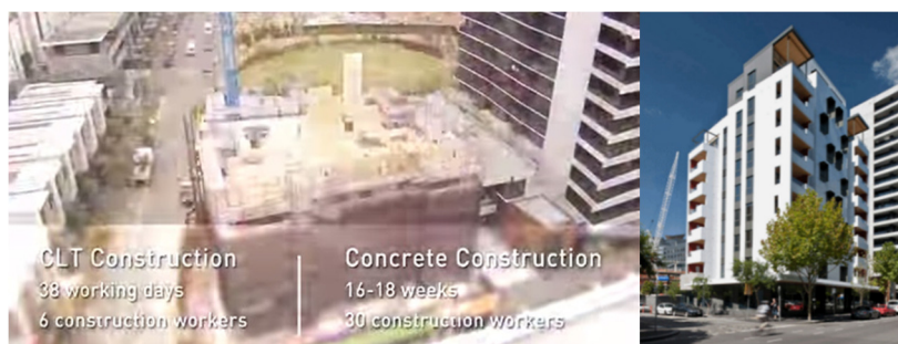
Imagem 4 – Edifício Forté, em Melbourne, Austrália. A chegada dos painéis prontos à obra, feitos em madeira com a tecnologia CLT, facilitou a montagem do edifício de 10 andares em prazo recorde.
