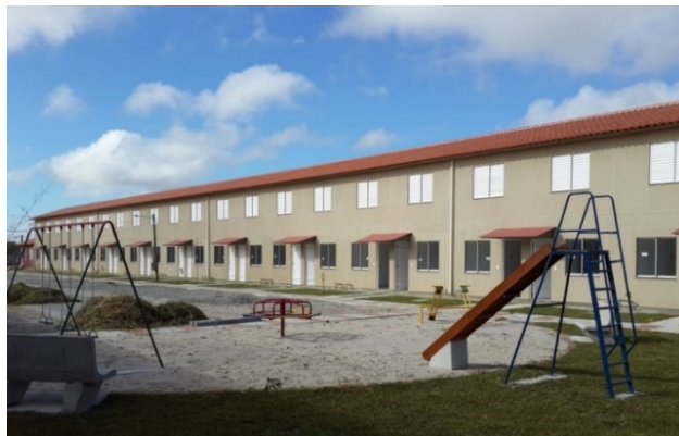
Imagem 11 –280 unidades habitacionais construídos em wood frame em Pelotas – RS.
