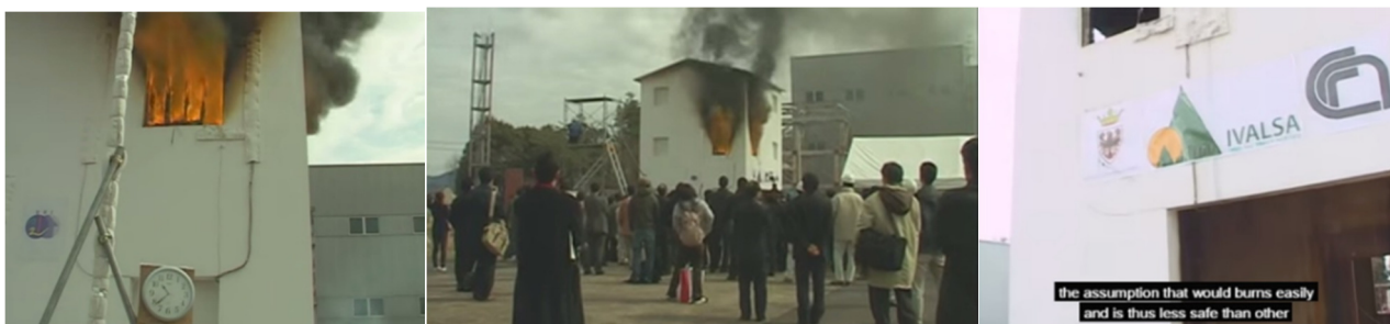
Imagem 5 – Testes feitos pelo IValsa para determinar a durabilidade das paredes em relação ao fogo
