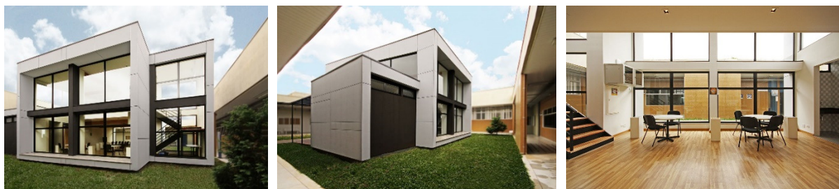
Imagem 10 – Casa Sustentável do SENAI criada com o objetivo de difundir o wood frame no Brasil
